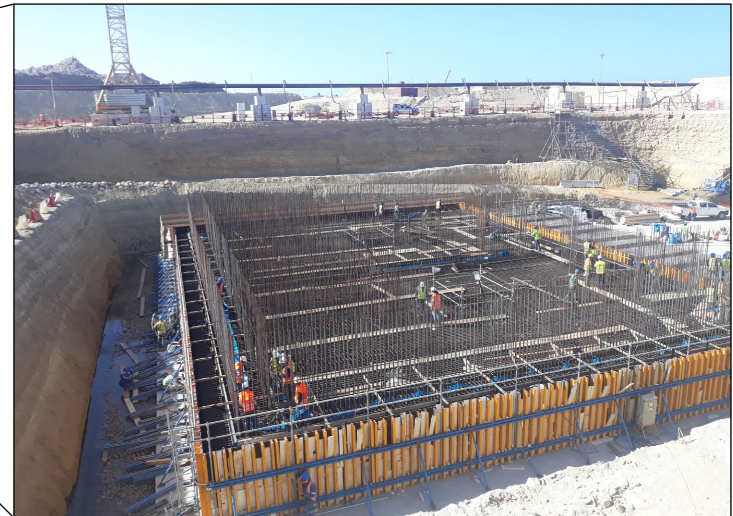
En 2021 se construyeron los cimientos de lo que probablemente sea una nueva torre de control, cerca del nuevo muelle.
