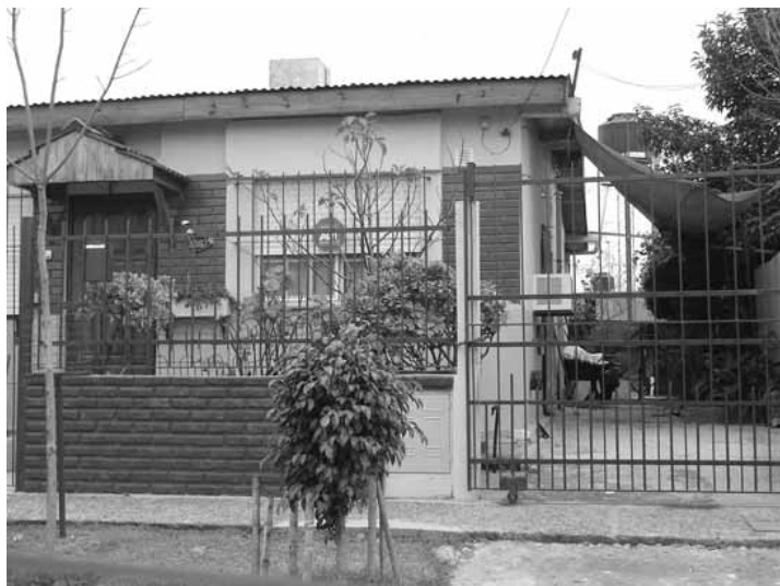
Con los micro-créditos se comenzó la construcción de esta vivienda.
