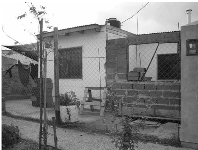
Vivienda construida a partir del PROMEBA; ampliación - en construcción- realizada con micro-créditos.
