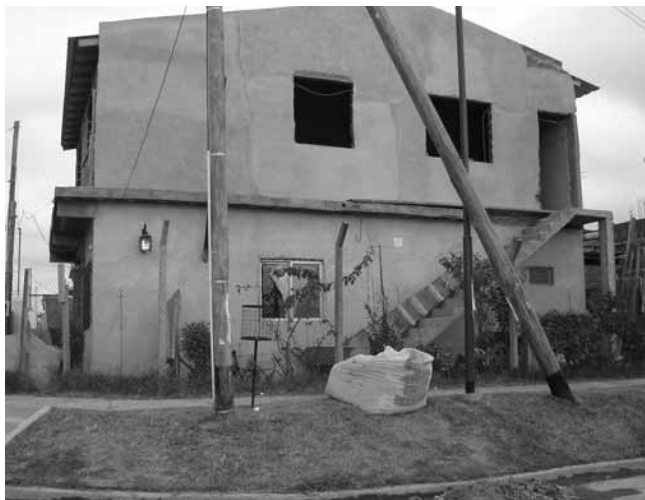
Vivienda en construcción con micro-créditos.
